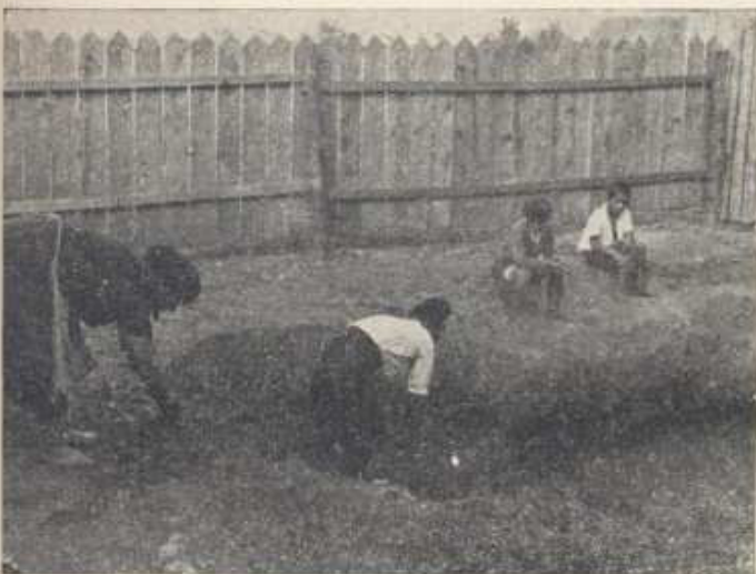
Fig. 1. — Prepararea lutului pentru lipitul sau bulgăritul casei.
