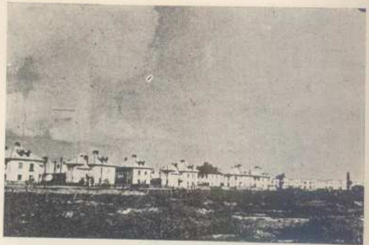
Fig. 27. — Grup de locuințe, realizate de Soc. Comunală de Locuințe Eftine. Parcelarea Iancului.
