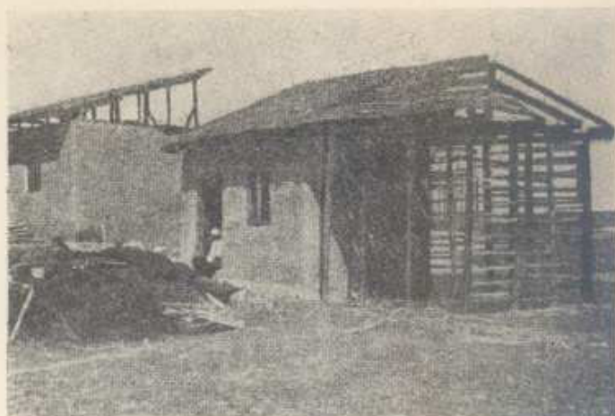
Fig. 2. — Casă cu acoperiș iar scheletul umplut cu lut și paie.
