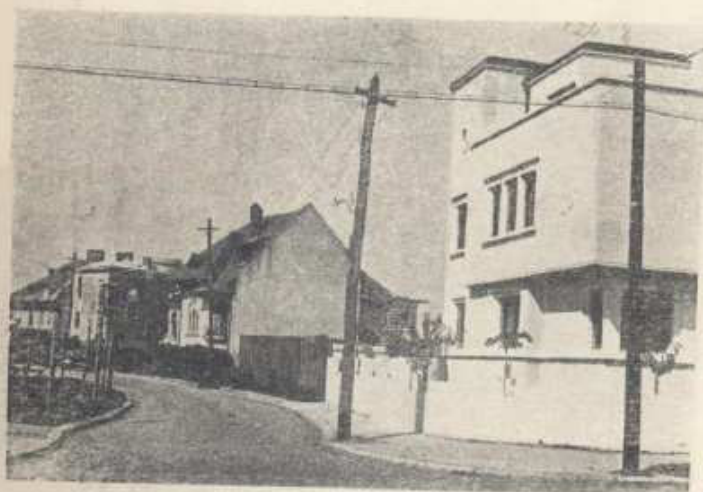
Fig. 28 — Parc Ferdinand. Locuințe eftine.
